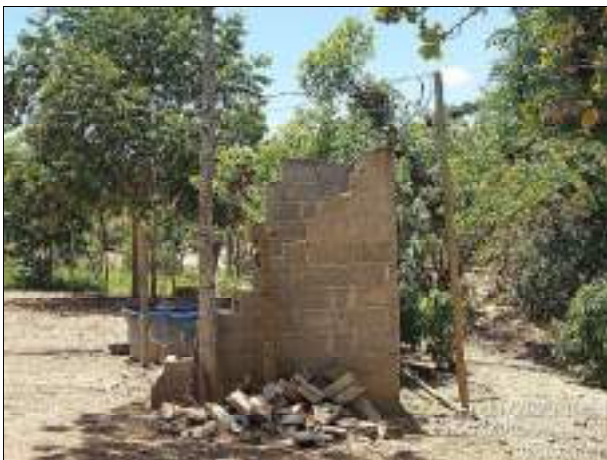
Foto 07: Poço Artesiano Comunitário.
