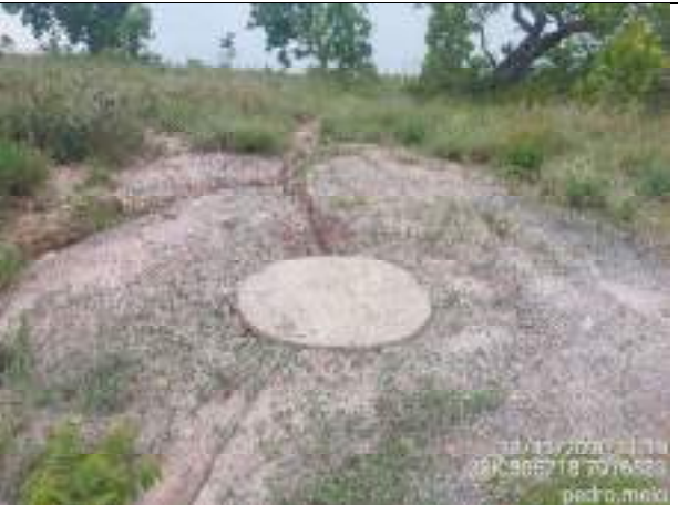
Foto 04: Poço Artesiano Comunitário.
