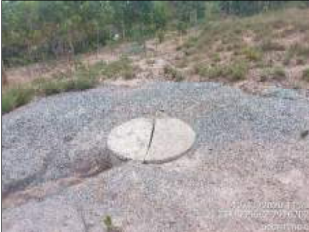
Foto 05: Poço Artesiano Comunitário.
