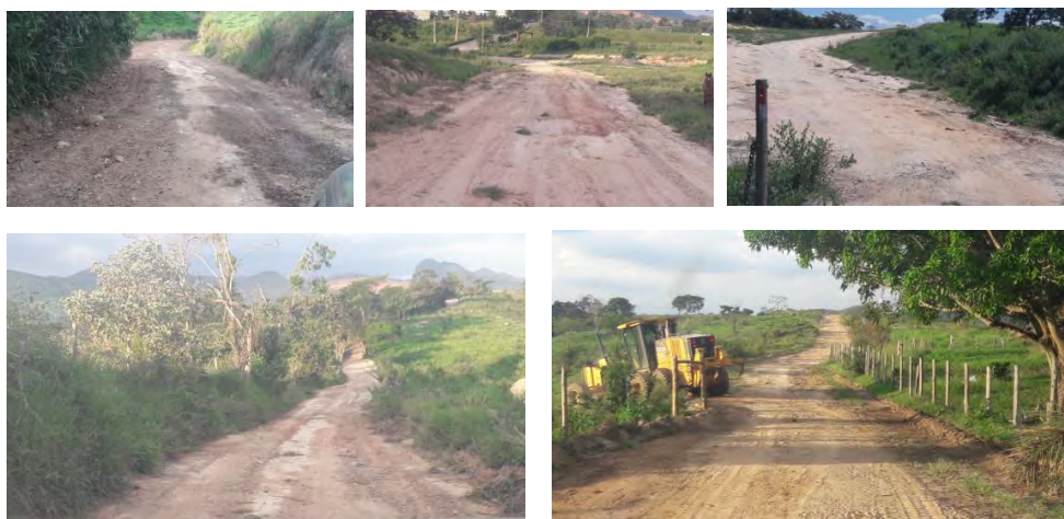
Foto 17: Fotos condição acesso Fazenda dos Côcos após manutenção – Depósito frente agropecuária. Data:09/03/2019
