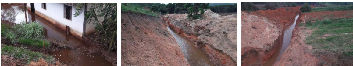
Foto 12: Fotos ponto 9 – Nível d'água abaixando após confecção do canal na casa do Sr. Pedro
