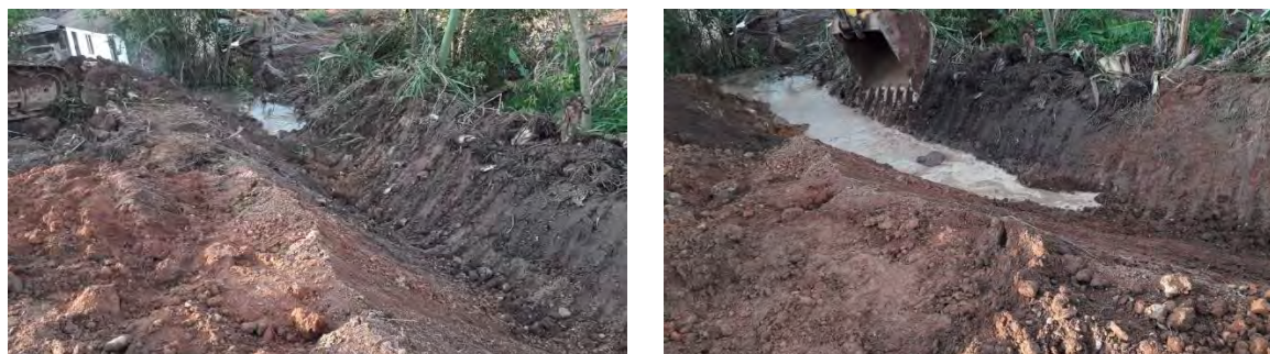
Foto 11: Fotos ponto 9 – canal para esgotar a água na casa do Sr. Pedro
