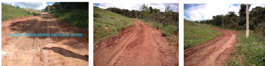
Foto 4: Fotos do acesso Aterro Sanitário antes da intervenção
