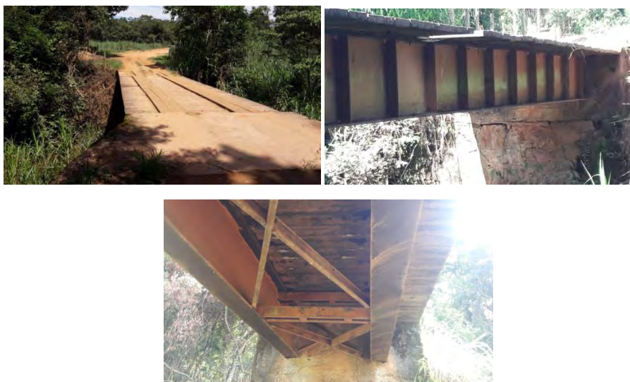
Foto 20: Fotos da ponte de madeira acesso Cantagalo (próximo ao Zé Linhares) para Melo Franco
