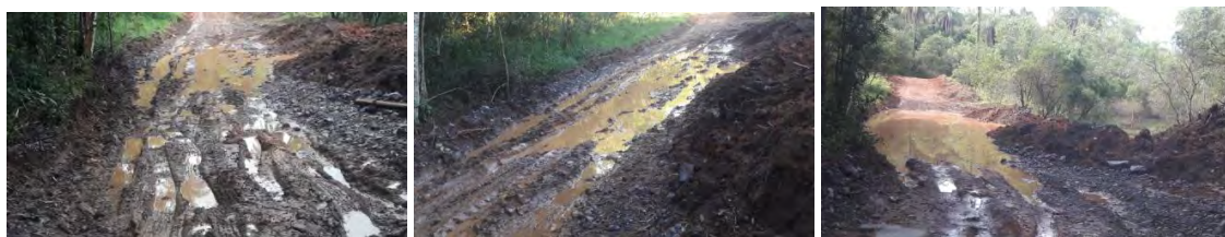
Foto 7: Fotos do acesso Fazenda dos Menezes antes das intervenções
