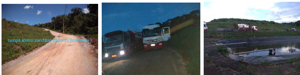
Foto 6: Fotos do acesso Aterro Sanitário após a intervenção
