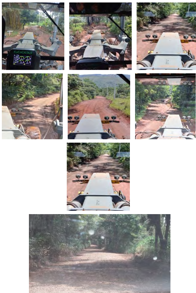
Foto 14: Fotos manutenção acesso Casa Branca para Córrego do Feijão
