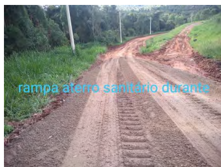
Foto 5: Fotos do acesso Aterro Sanitário durante a intervenção
