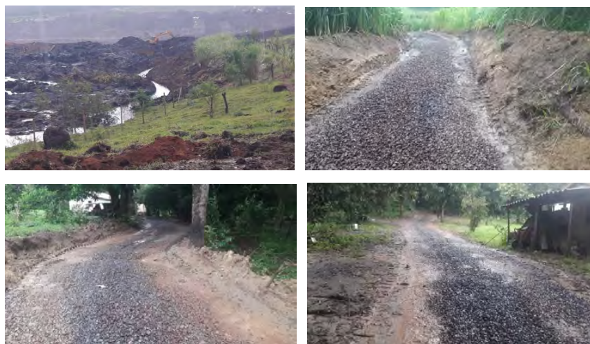
Foto 13: Fotos ponto 1 – canal para esgotar a água na propriedade Sr. Antônio Francisco Maia e manutenção acessos
