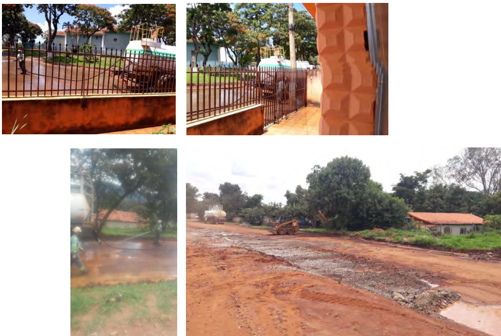
Foto 19: Fotos Limpeza e manutenção das vias da comunidade do Tejuco e Córrego do Feijão. Datas:09 e 11/03/2019
