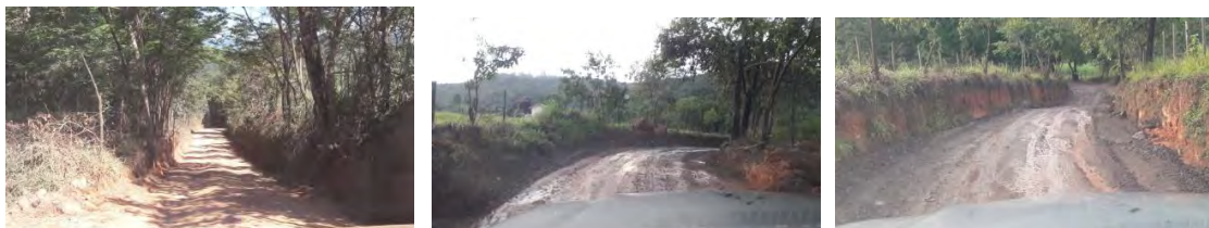
Foto 15: Fotos manutenção acesso Cantagalo – Melo Franco. Data:09/03/2019
