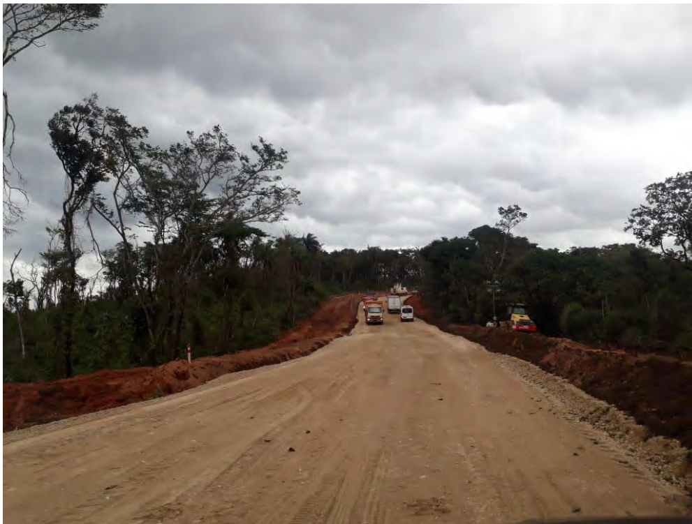
Brumadinho Acesso Manejo de Rejeitos – regularização e nivelamento de lastro com brita
