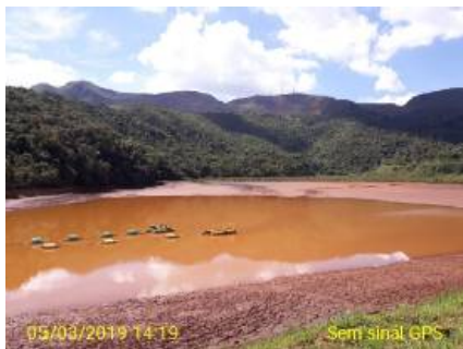
Figura 18 - Vista parcial da Barragem BVI
