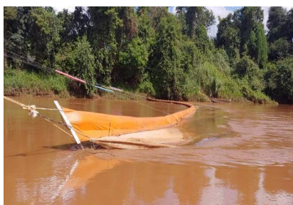
Figura 04 - Membrana de contenção instalada no município próximo a São José da Varginha, MG.
