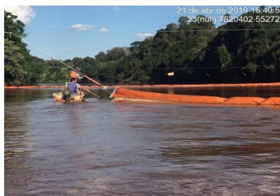
Figura 07 - Atividades na membrana de contenção instalada no município próximo a São José da Varginha, MG.
