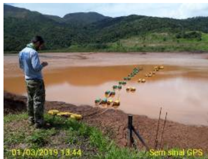
Figura 19 - Equipe CLAM realizando vistoria na Barragem BVI
