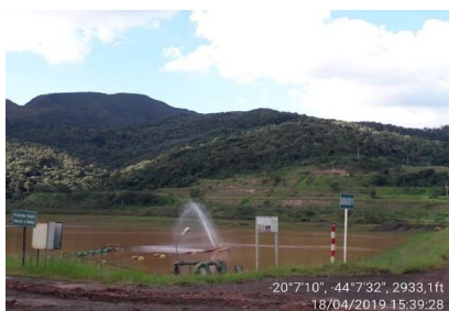
Figura 16 - Vista da barragem B-IV da Mina Córrego do Feijão.
