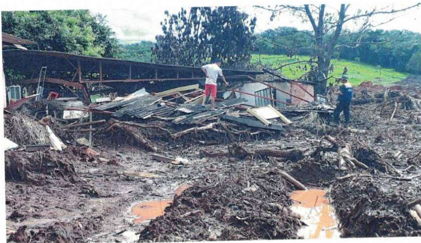
Figura 3 – Escombros da edificação
