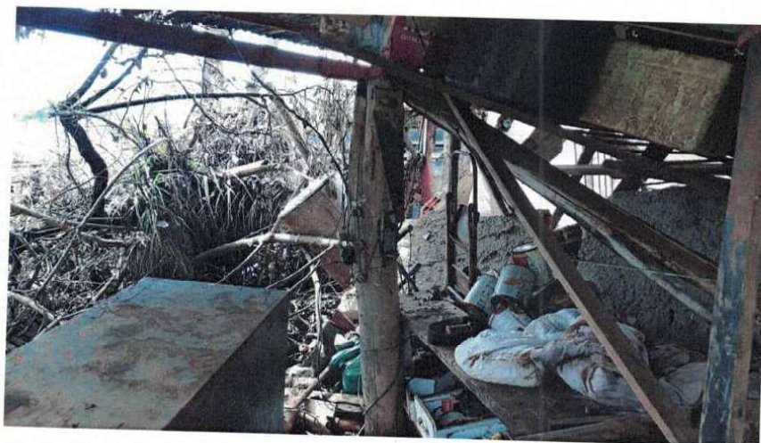
Figura 3 – Escombros da edificação
